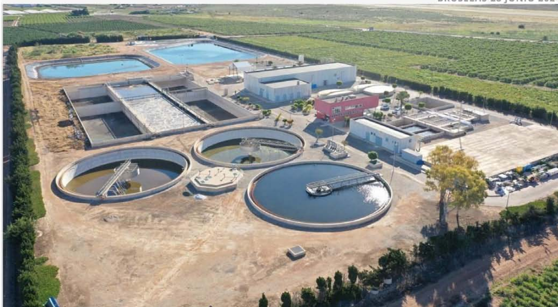
Depuradora de San Javier Fuente: Región de Murcia
