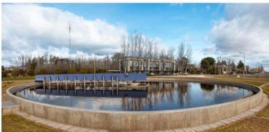
Decantador secundario EDAR La Golondrina
