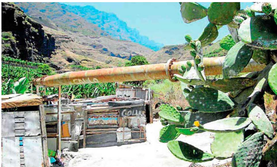
Imagen de archivo de tuberías en el municipio palmero de Tazacorte. c7
