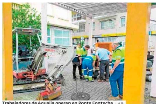
Trabajadores de Aqualia operan en Ponte Fontecha. L.A.R.
